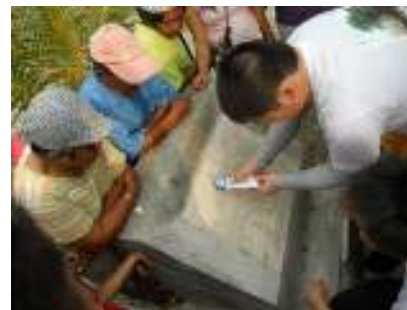
接合面にボンドを付けます。
