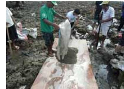
竹は波よけのためではなく、囲いの石が崩れないための補強です。囲いの石はセメントで固めます。日本からの職人の指導でセメントを作りました。
