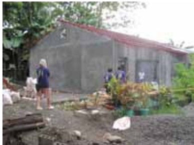
建設中の校舎です。
