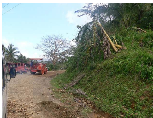
凸凹がひどい道。台風の影響で土砂崩れも。 道の復旧作業の様子。
